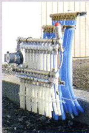
Komplet montering 2 grens til færdig blandesløjfe
