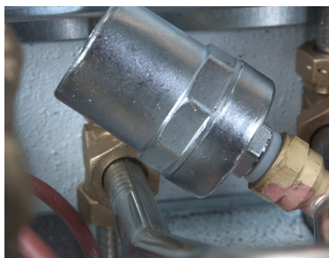
Figur 3 - Trykudligner med kontraventil
